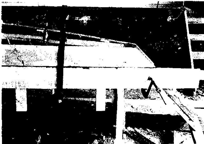
Fig.133 S'assurer qu'il y en a sur les côtés des étraves. Fixer à l'étrave comme pour le bouchain mais avec des clous de 7 cm
