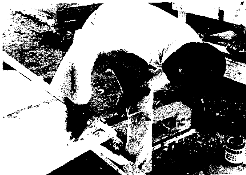
Fig.180 Si l'on désire éviter l'usage d'un gabarit on peut clouer en place une planche de 2 x 14 x 70 cm
