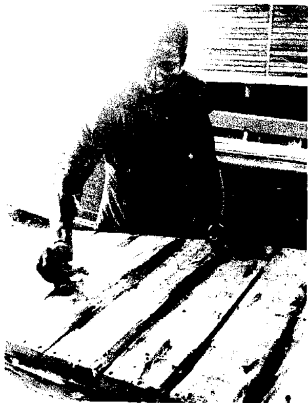
Fig.170 Nettoyer le surplus de produit d'étanchéité aux joints Fig.170 Clean off surplus putty
