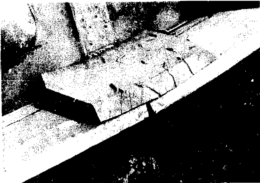
Fig.15 Les joints sont de mauvaise construction Fig.15 Poorly constructed planking joints
