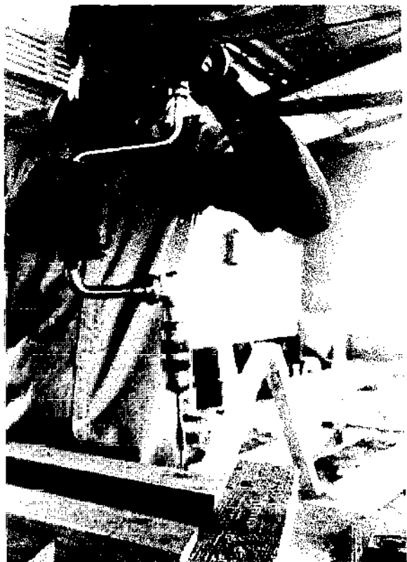
Fig.75 Frotter le filetage des vis avec du savon pour faciliter le vissage Fig.75 Rub screw threads with soap for easy screwing
