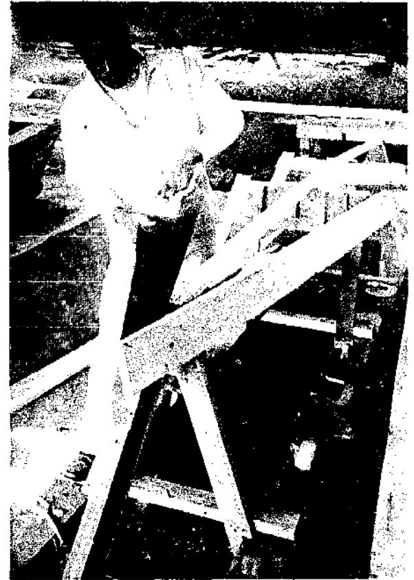
Fig.110 Scier le bout de bouchain dépassant de l'étrave
