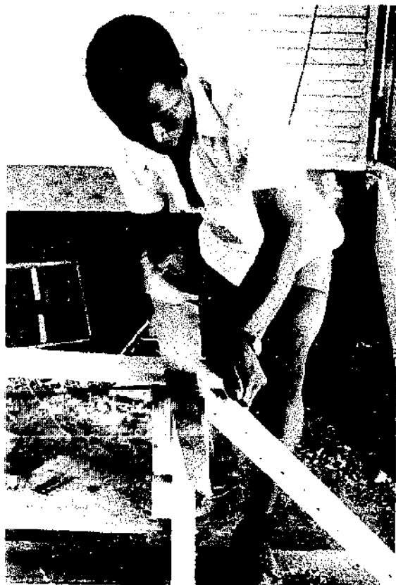
Fig.91 On scie les bouts dépassant des porte-étraves
