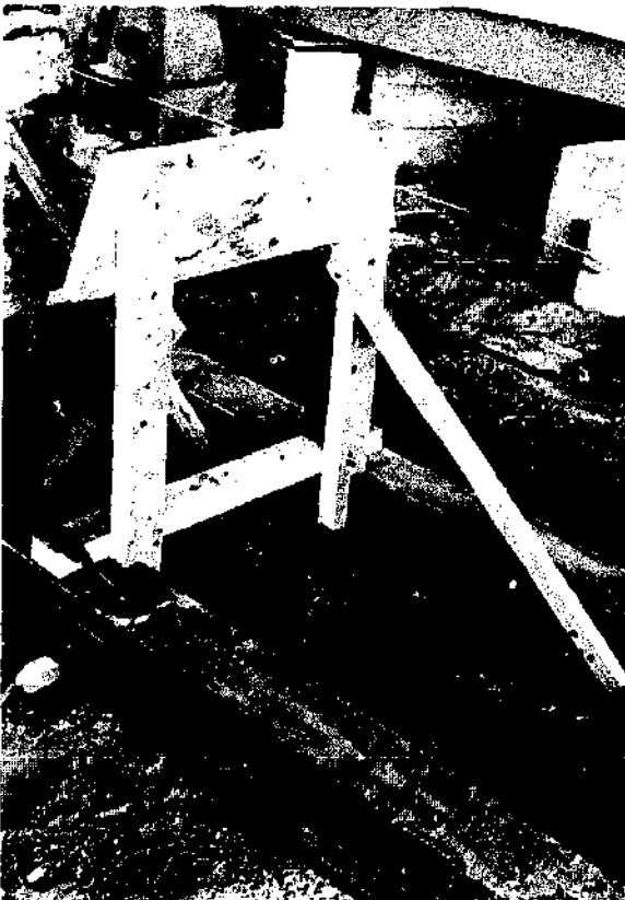
Fig.47 On fixera des arc-boutants entre les montants et les longerons afin que les montants restent à l'équerre Fig.47 Struts are fixed to the uprights and runners to ensure that the uprights remain square
