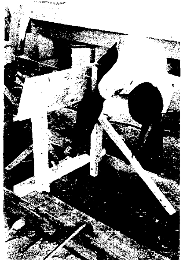
Fig.48 On fixera ensuite les pieds des montants aux longerons, par deux clous de 10 cm à chaque pied Fig.48 The uprights are then nailed to the runners with two 4" nails each
