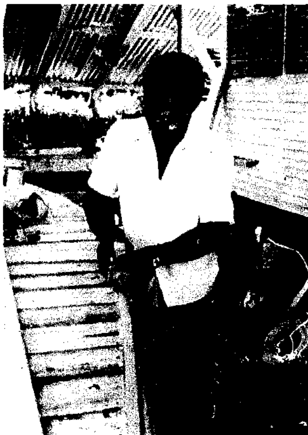
Fig.178 Raboter le couvre-joint à l'égalité du fond
