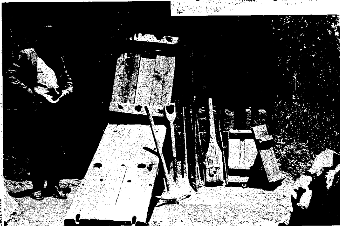
FIGURE 59 : LES OUTILS DU PISEUR PERUVIEN (HUANCAVELICA)
