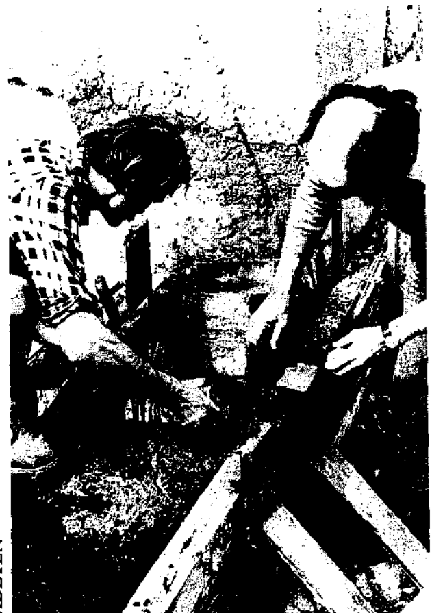
FIGURE 311 : POSE DES PREMIERES BRIQUES SUR LE SOUBASSEMENT
