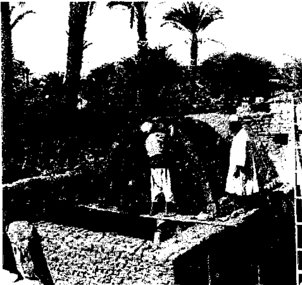
FIGURE 310 : LE MAÇON NUBIEN S'APPRETE A « COLLER » LA BRIQUE SUR LA COUCHE DE MORTIER. ON DISTINGUE SUR UNE FACE DE LA BRIQUE LES SILLONS, CREUSES AU MOULAGE, ET QUI AMELIORENT L'ADHERENCE DE LA BRIQUE AU MORTIER.
