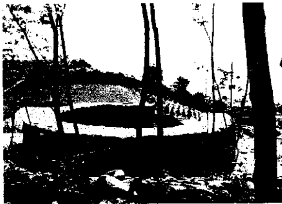
▲ FIGURE 96 : EXPERIENCE DU GROUPE « PALAFITTE » DE L'UP D'ARCHITECTURE DE GRENOBLE EN 1975 AU PIN (ISERE) - CONSTRUCTION CIRCULAIRE EN PISE
