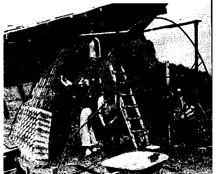
FIGURE 314 : LE MAÇON EN HAUT À GAUCHE VÉRIFIE QUE LE PROFIL DE LA VOUTÉ RESTE CONSTANT
