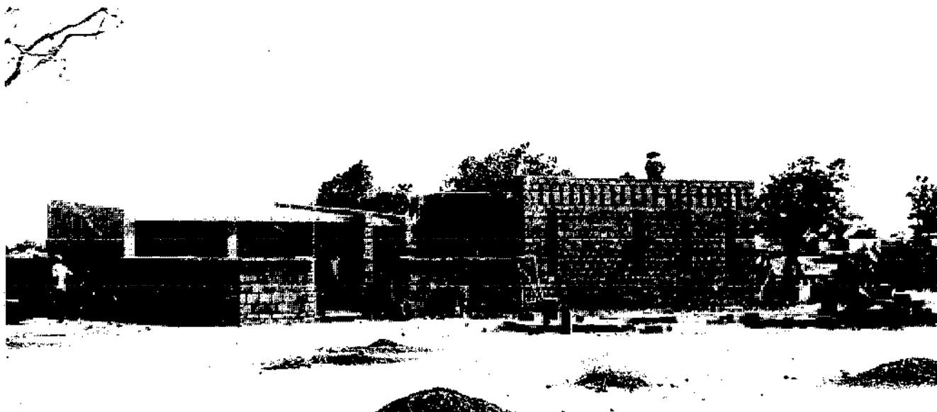
FIGURE 224 : REALISATION EN BRIQUES DE TERRE COMPRESSEES A CISSIN, OUAGADOUGOU (HAUTE-VOLTA)
