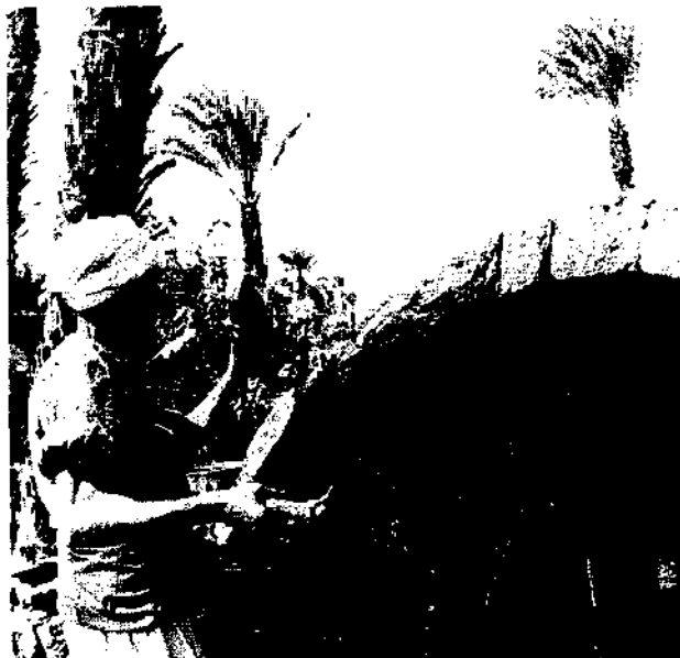
FIGURE 310 : LE MAÇON NUBIEN S'APPRETE A « COLLER » LA BRIQUE SUR LA COUCHE DE MORTIER. ON DISTINGUE SUR UNE FACE DE LA BRIQUE LES SILLONS, CREUSES AU MOULAGE, ET QUI AMELIORENT L'ADHERENCE DE LA BRIQUE AU MORTIER.
