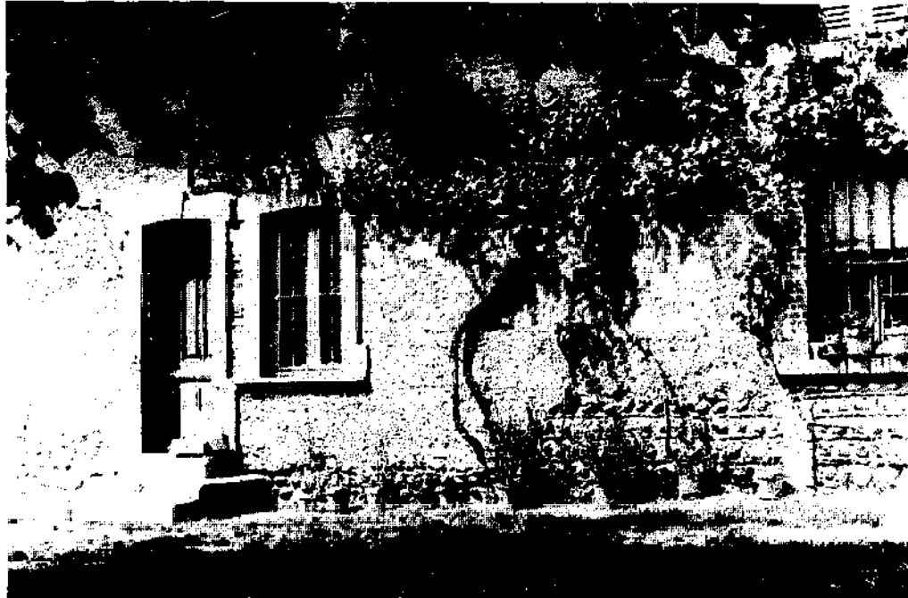
FIGURE 47 : FAÇADE DE LA PARTIE HABITATION
