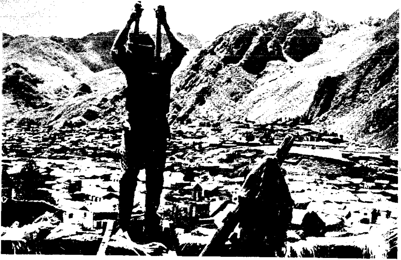
5 - On la dame avec le pisoir (fig. 61). On utilise parfois un pisoir à deux manches encadrant un gros morceau de bois. L'installation de la banche sur le mur demande 20 minutes et son remplissage, par trois hommes et deux enfants de 40 à 50
