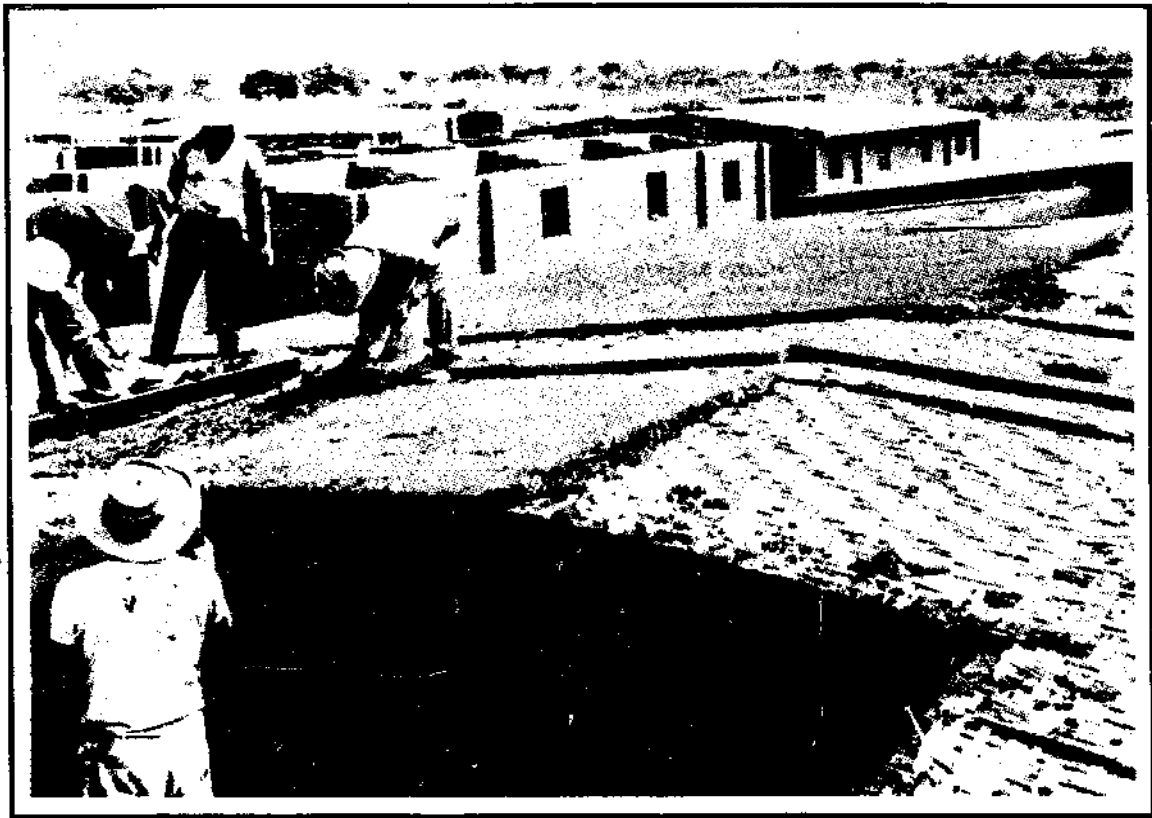
FIGURE 301 : COULAGE DE LA TERRE STABILISEE SUR LE TOIT D'UNE DES MAISONS DE CAYALTI (PEROU). CF. CHAPITRE « ADOBE »
