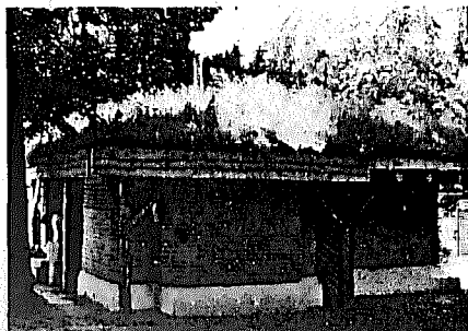
5 Versuchsbau der Gesamthochschule Kassel (der vordere Teil wurde mit der Lehmstrang- -prüftechnik errichtet).
