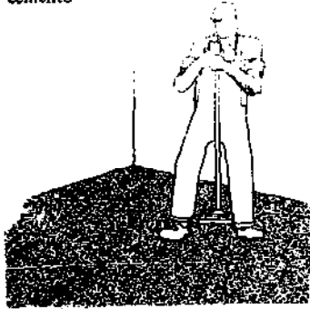
Worker tamping ground for cement layer Operario apisonando el suelo para tender el firme de cemento
