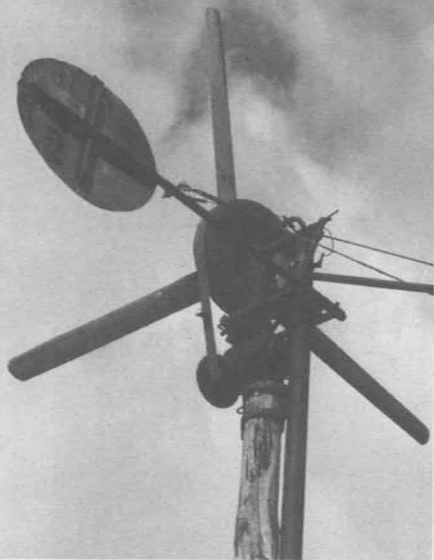
Das erste Windrad dieser Bauart (1986), 2,5 m \phi mit Drehstrommotor als Generator, am Giebel einer Scheune befestigt.
