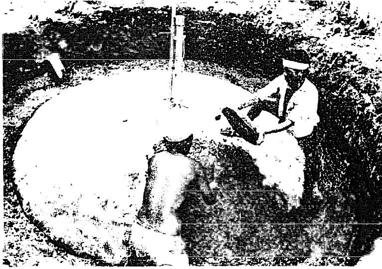
9 Pouring concrete on dome
