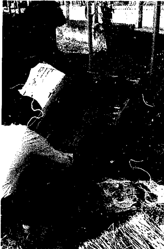
Abb. 6.19 Erste Pajón-Schicht, auf die Erd-Kalk-Fläche gepreßt, wie unter Abb. 6.18.
