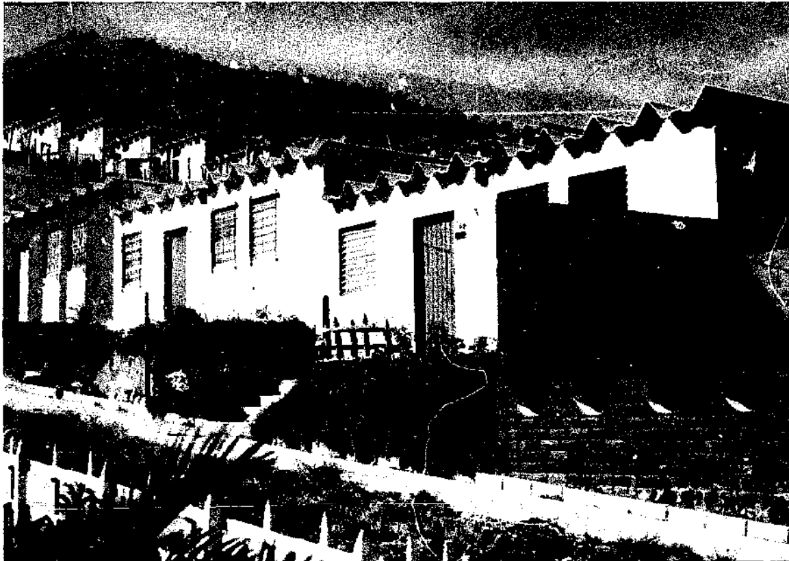
Abb. 3.16 Asbestzement-Trogplattendächer (canaletas) in El Salvador
