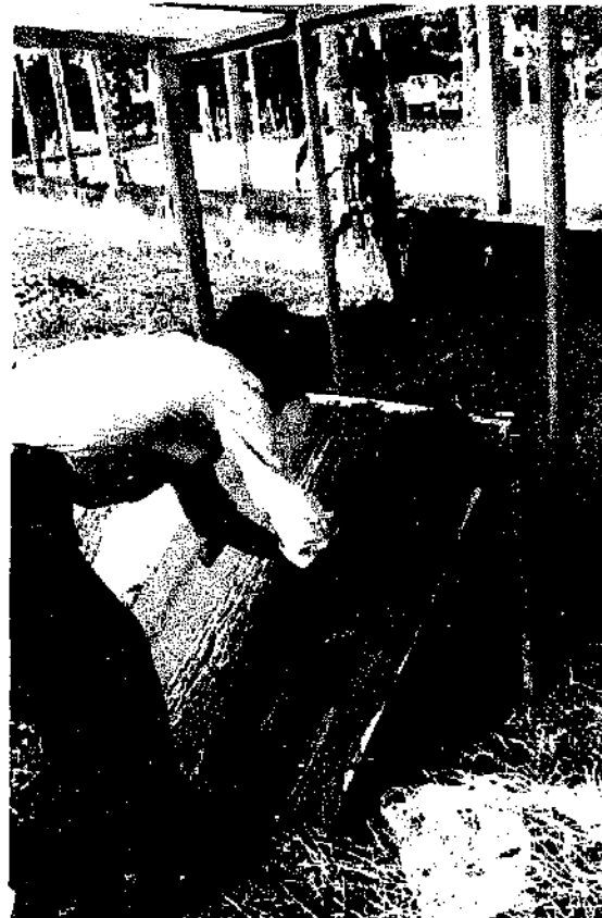
Abb. 6.20 Mit dicker Erd-Kalk-Mischung getränktes Sisalsack-Material, die letzte Pajón-Lage überdeckend aufgeklebt, um dadurch den Pajón festzuhalten und nach dem Trocknen Verschiebungen zu verhindern.
