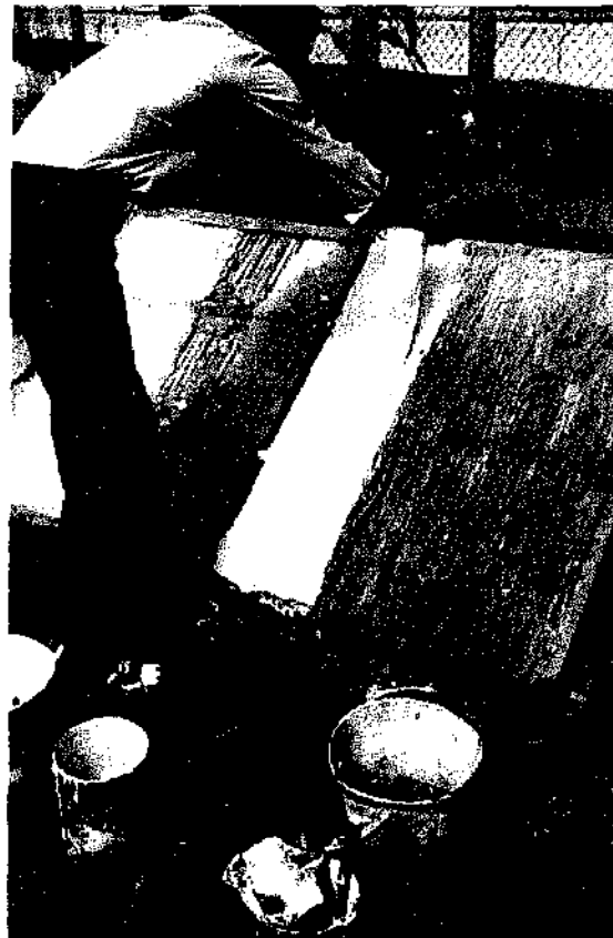
Abb. 6.23 Teilweise Verstärkung der Kalkschicht mit Baumwollstoff. Fig. 6.23 Part of the limewash coating was reinforced with strips of cotton textile.
