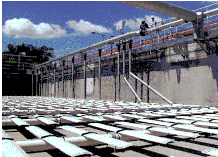
Fig. 8 Diffused Air Aeration (Aquatec-Maxcon, 2004a)
