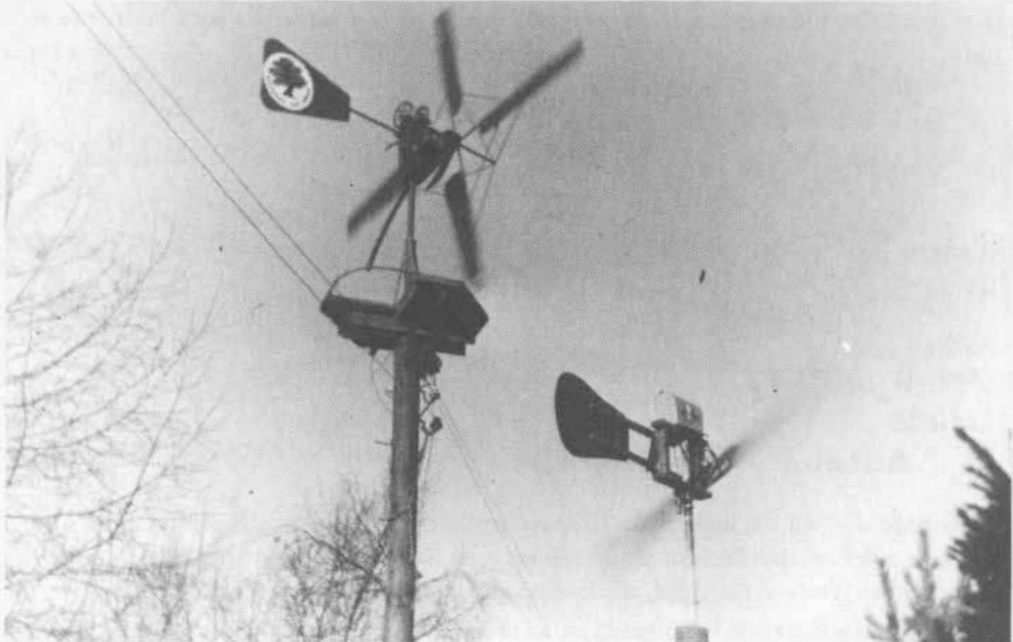
So fingen wir an: 2 Sperrholzflügel, Keilriemen (Einbandbild, 1977), 4 Sperrholzflügel, 2-stufiges Ketten-
