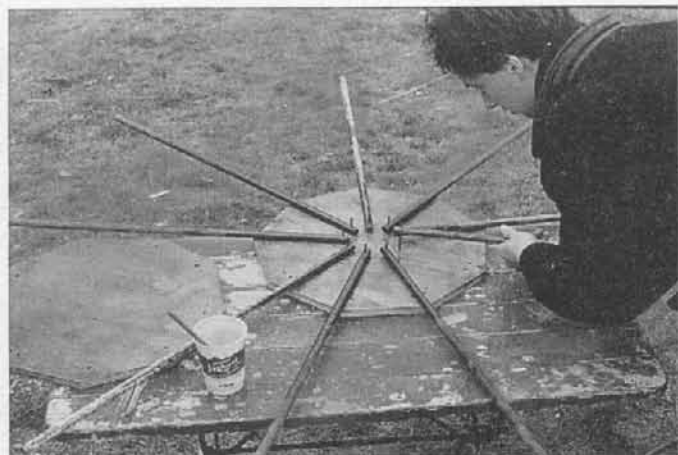
Nabenscheiben gebohrt, Speichen montieren. Schutzanstrich Firnis.
