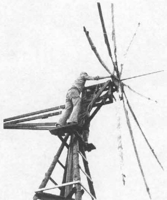
het plaatsen en controleren van het wiekenstel mounting and inspection of the wings
