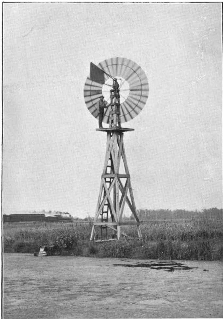
VIEW OF MILL NO. 19—12-FOOT GEM.
